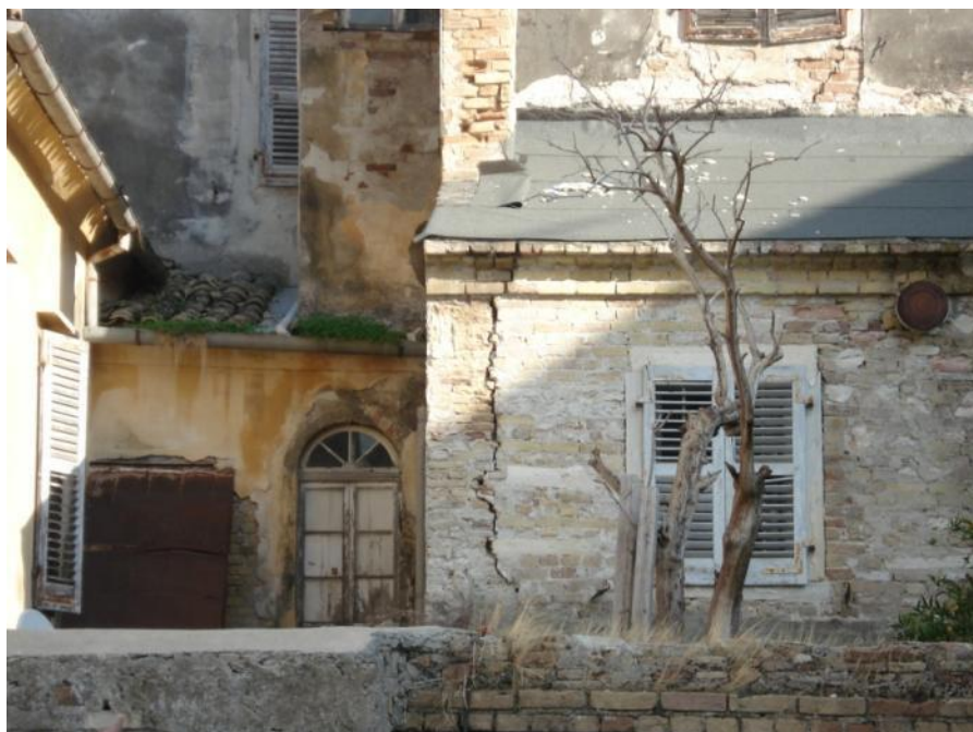
Φωτ. 7 Δυτική πλευρά (όψη Πλατεία Βλάχου)
