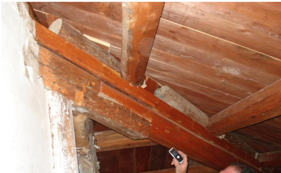
Φωτ. 14 προσφάτως αντικατασταθείσα στέγη
