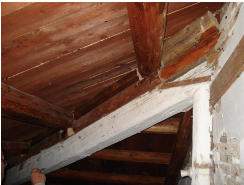
Φωτ. 15 τμήμα της στέγης η οποία κατασκευάστηκε πρόσφατα
