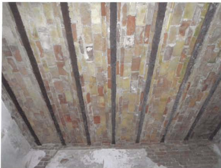
Οροφή κατασκευασμένη από συμπαγείς οπτόπλινθους
