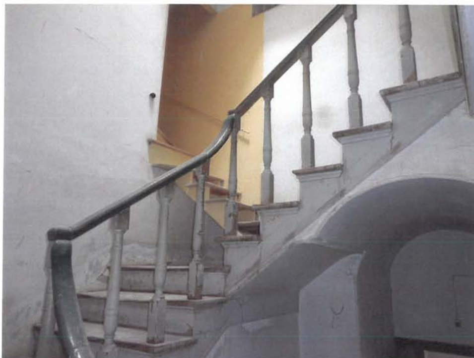
Κεντρικό κλιμακοστάσιο και μικρότερη κλίμακα προς την υποστέγη
