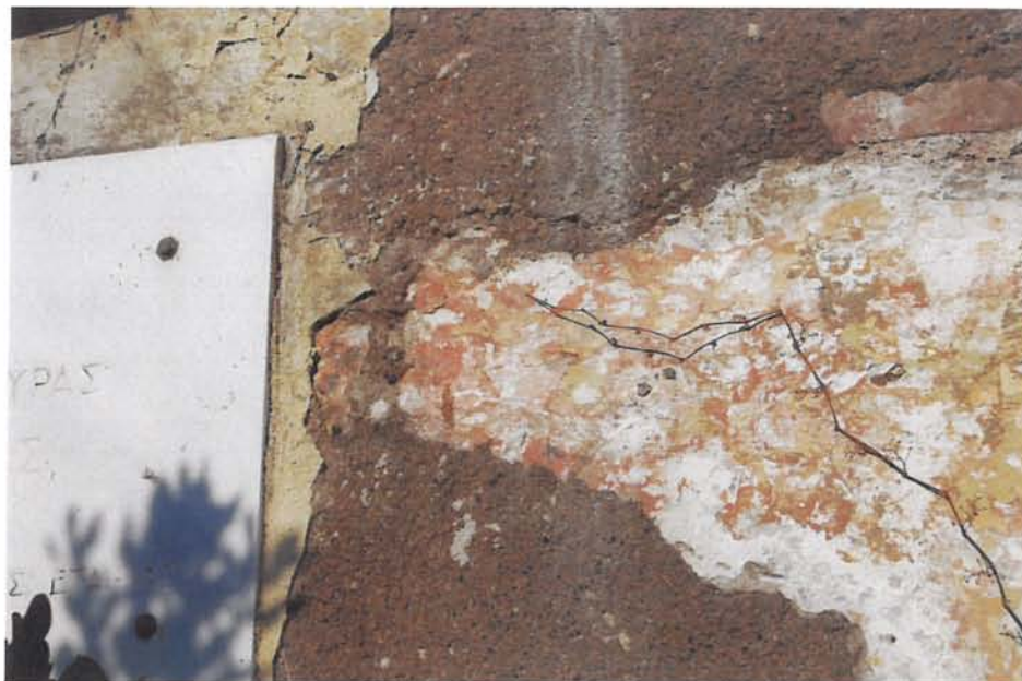
Χρωματισμοί στο πρόσκτισμα στην όψη επί της οδού Καποδιστρίου
