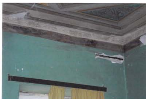
ΦΘΟΡΕΣ ΣΤΑ ΕΣΩΤΕΡΙΚΑ ΕΠΙΧΡΙΣΜΑΤΑ ΣΤΟ ΧΩΡΟ 01_1 ΑΠΟ ΟΞΕΙΔΩΜΕΝΟ ΕΝΤΑΤΗΡΑ
