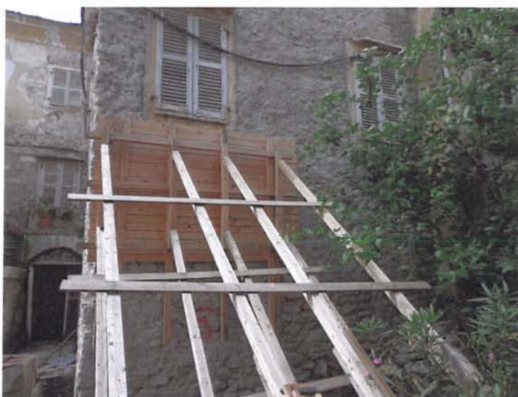
Ξύλινες δοκοί και αντηρίδες
