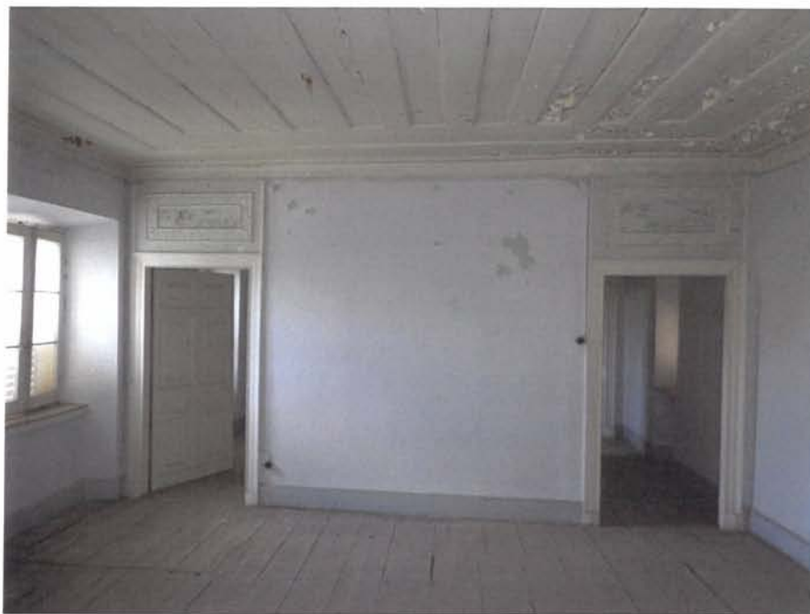
Ξύλινα δάπεδα & οροφές - Γύψινος διάκοσμος
