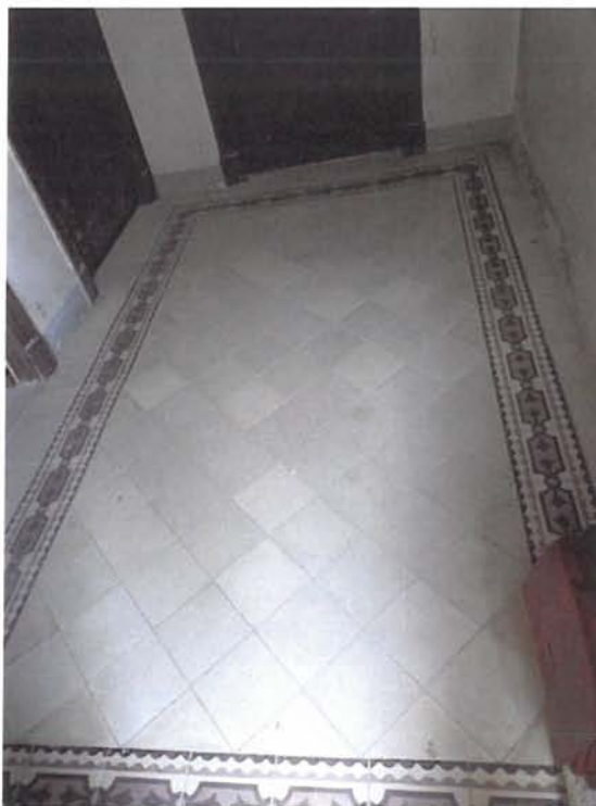
Δάπεδο από κεραμικά πλακίδια
