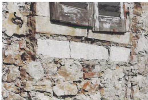
ΛΙΘΙΝΟ ΠΕΡΙΘΥΡΩΜΑ ΑΠΟ ΠΟΡΟΛΙΘΟ ΣΤΗ ΒΟΡΕΙΟΑΝΑΤΟΛΙΚΗ ΓΩΝΙΑ ΤΟΥ ΧΩΡΟΥ 01_19
