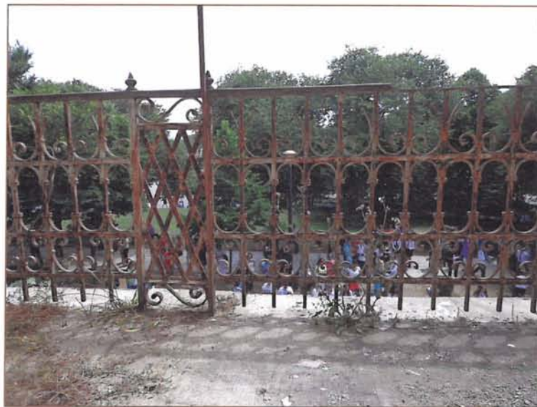
Λεπτομέρεια κιγκλιδώματος εξώστη
