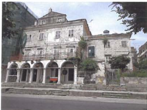
ΑΠΟΨΕΙΣ ΚΤΙΡΙΟΥ ΑΠΟ ΤΗΝ ΟΔΟ ΚΑΠΟΔΙΣΤΡΙΟΥ
