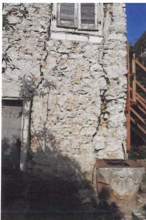
Αποκόλληση στη συναρμογή εγχάρσιων τοίχων
