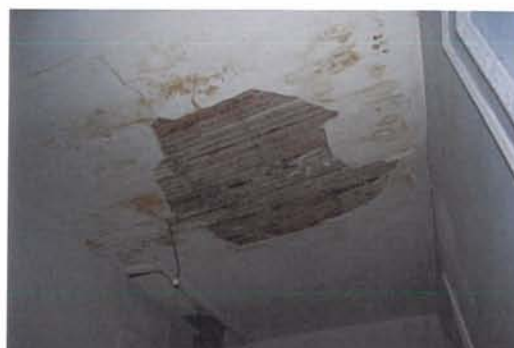
ΚΑΤΑΡΕΥΣΗ ΕΠΙΧΡΙΣΜΑΤΟΣ ΟΡΟΦΗΣ ΣΤΟΝ ΧΩΡΟ 01_4
