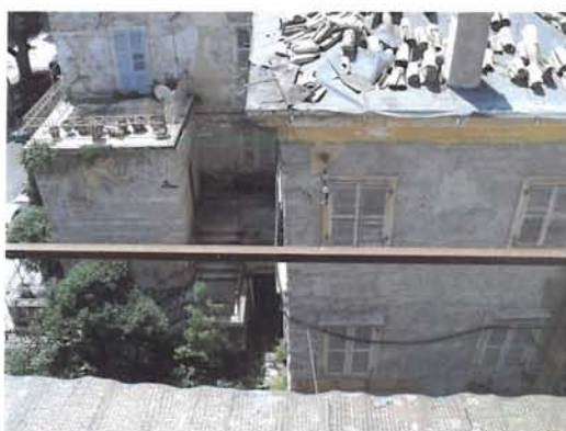
ΑΠΟΨΕΙΣ ΚΤΙΡΙΟΥ ΑΠΟ ΤΗΝ ΟΔΟ ΣΕΡΕΜΕΤΗ
