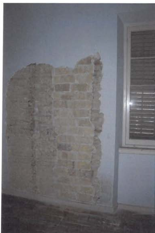
Διαμόρφωση καμινάδας με οπτόπλινθους
