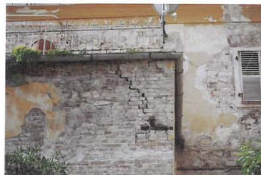
ΕΞΩΤΕΡΙΚΗ ΤΟΙΧΟΠΟΙΪΑ ΤΟΥ ΧΩΡΟΥ 01_12 ΑΠΟ ΣΥΜΠΑΓΕΙΣ ΟΠΤΟΠΛΙΝΘΟΥΣ
