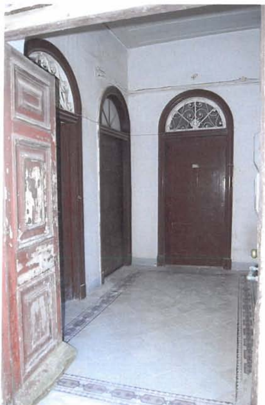
Εξωτερική είσοδος πρώτου ορόφου
