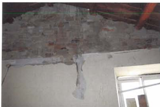
ΔΙΑΜΟΡΦΩΣΗ ΚΑΜΙΝΑΔΑΣ ΜΕ ΣΥΜΠΑΓΕΙΣ ΟΠΤΟΠΛΙΝΘΟΥΣ ΣΤΟΝ ΧΩΡΟ 03_10
