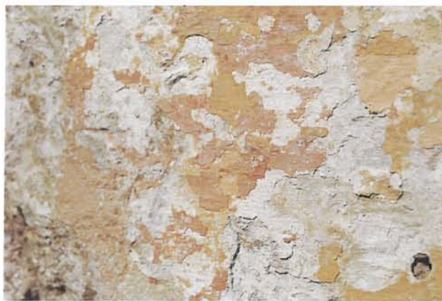
Άποψη διαδοχικών χρωματισμών τοιχοποιίας
