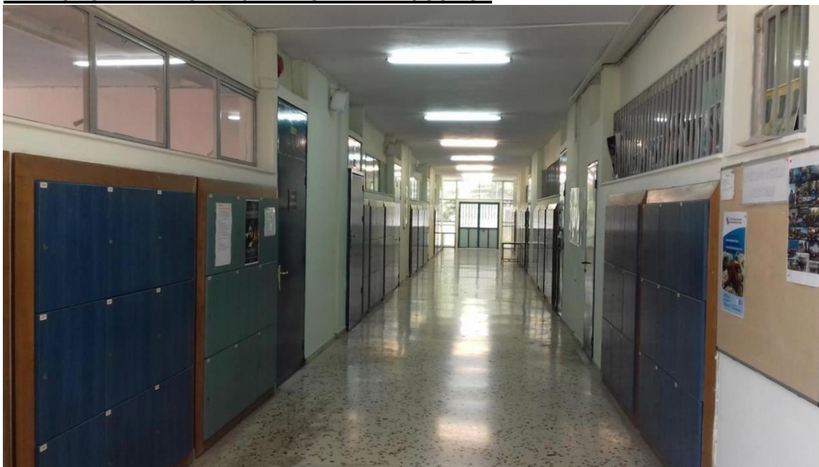
ΔΙΑΔΡΟΜΟΣ ΜΩΣΑΪΚΟ ΚΑΙ ΦΩΤΙΣΜΟ ΛΑΜΠΕΣ ΦΘΟΡΙΟΥ
