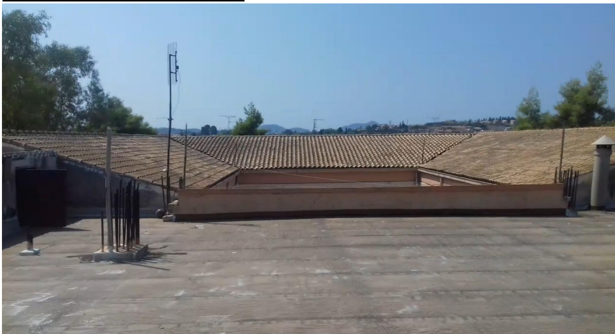
ΣΤΕΓΗ ΑΝΕΥ ΘΕΡΜΟΜΟΝΩΣΕΩΣ 7 ΟΥ Δ.Σ.
