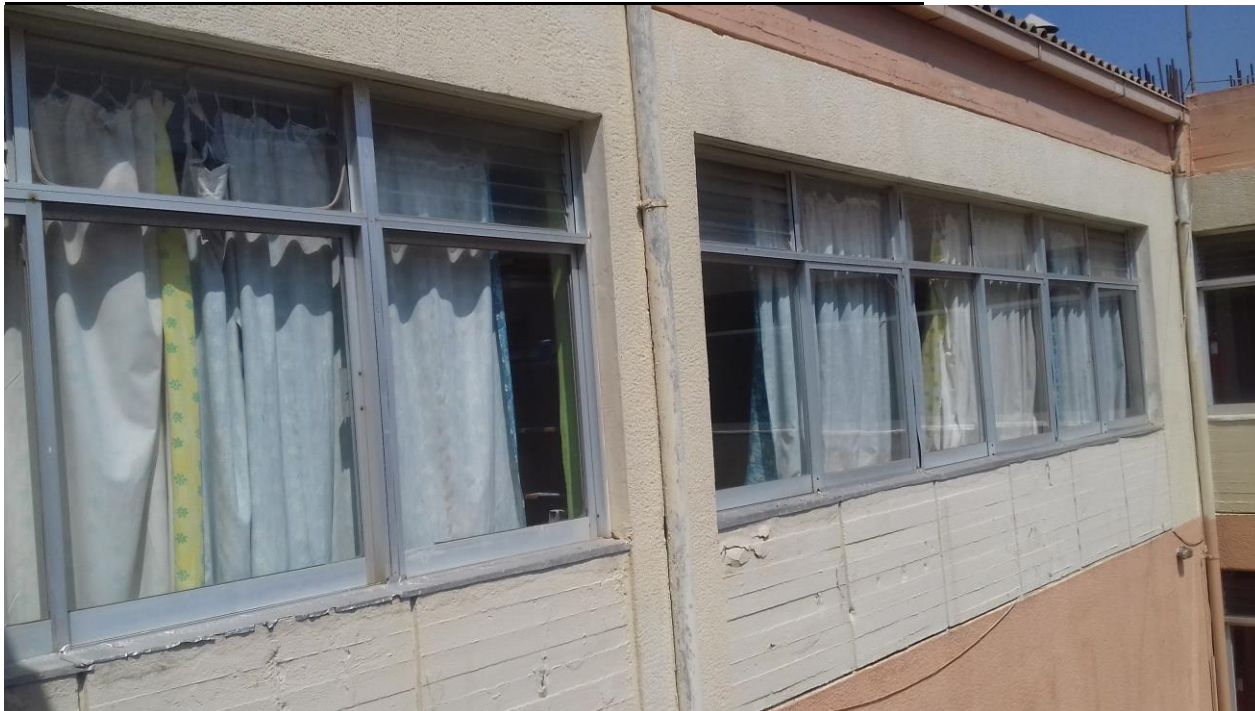
ΚΟΥΦΩΜΑΤΑ ΣΥΡΩΜΕΝΑ ΑΛΟΥΜΙΝΙΟΥ ΠΑΛΑΙΑ 7 ΟΥ ΔΗΜΟΤΙΚΟΥ ΣΧΟΛΕΙΟΥ
