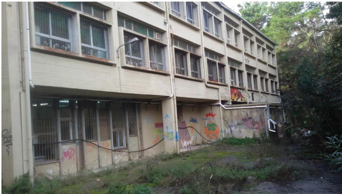
ΠΙΣΩ ΟΨΗ ΤΟΙΧΟΙ ΠΛΗΡΩΣΕΩΣ ΑΠΟ ΩΠΙΣΜΕΝΟ ΣΚΥΡΟΔΕΜΑ ΕΞΩΤΕΡΙΚΑ ΑΝΕΠΙΧΡΗΣΤΟΙ
