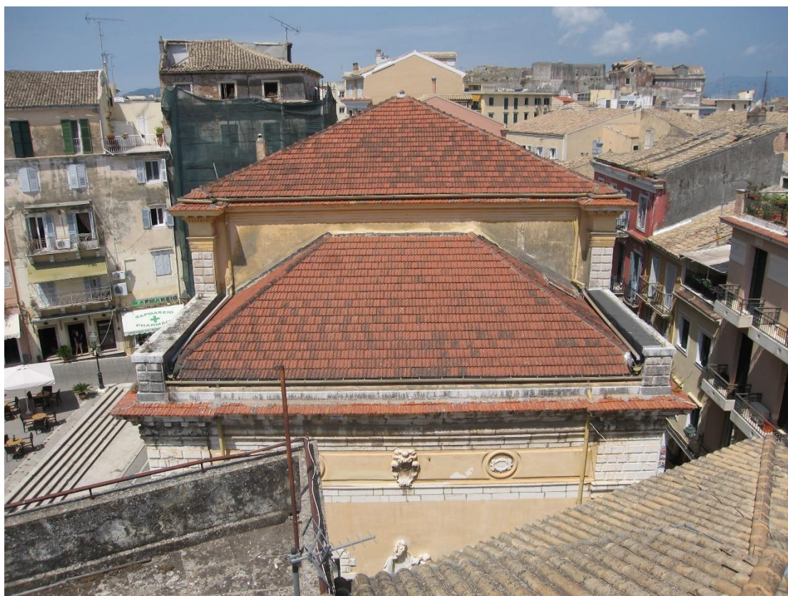
Εικόνα 4: Άποψη της στέγης από Ανατολικά
