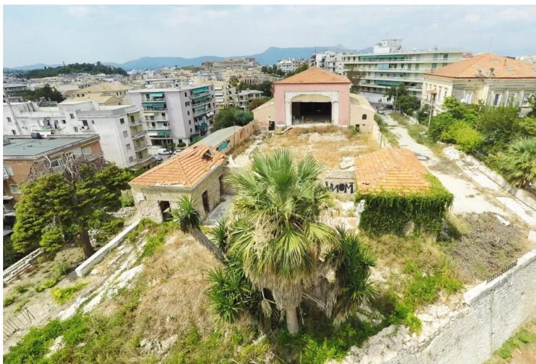
Εικ.5 Άποψη της νότιας πλευράς του θεάτρου πριν τη κατάρρευση της στέγης της σκηνής
