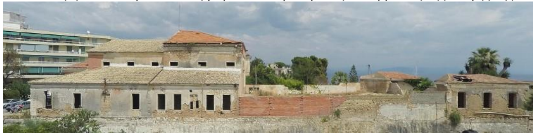
Εικ.3 Η δυτική πλευρά του θεάτρου πριν τη κατάρρευση της στέγης της σκηνής
