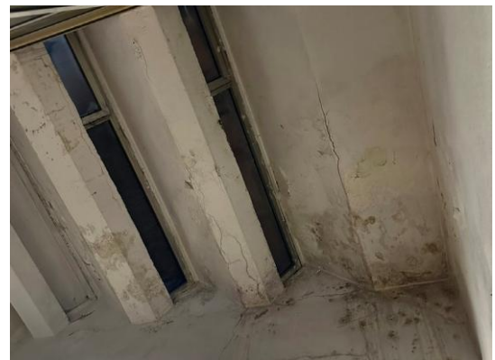
60, 61. Αχρηστευμένοι κεκλιμένοι φεγγίτες (skylights) που φώτιζαν τα καμαρίνια των ηθοποιών, στην πτέρυγα επί της Γ. Θεοτόκη έχουν καλυφθεί από μεταγενέστερο στέγαστρο
