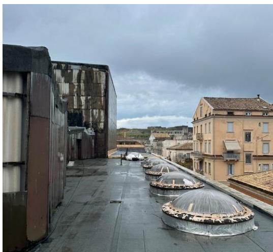
62, 63. Η απόληξη του όγκου της σκηνής και της κεντρικής αίθουσας του Θεάτρου καθώς και η οριζόντια επιφάνεια του δώματος χρήζουν καθολικής επισκευής
