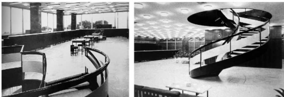
46, 47. Αναστασία Τζάκου, Εθνική Τράπεζα της Ελλάδος, Πάτρα, 1966, εσωτερικό, κλίμακα προς όροφο
