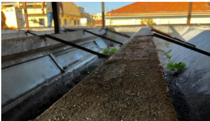
60, 61. Αχρηστευμένοι κεκλιμένοι φεγγίτες (skylights) που φώτιζαν τα καμαρίνια των ηθοποιών, στην πτέρυγα επί της Γ. Θεοτόκη έχουν καλυφθεί από μεταγενέστερο στέγαστρο
